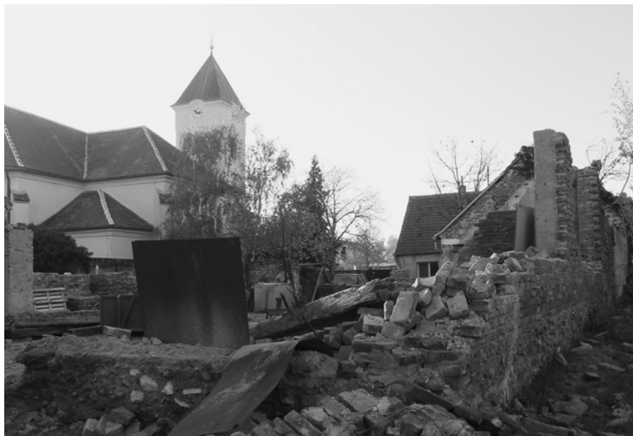
Obr. 9. Průběh demolice hospodářských budov domu čp. 51 ve Strachotíně. Vpravo vzadu ještě stojící původní zeď. Foto Jana Křivánková, 2020/2021.
